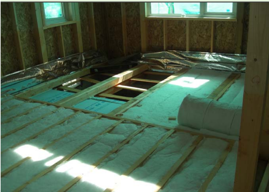
床断熱材の施工 高性能GW16k100+50 ㉿ 付加断熱 XPS板2種25 ㉿
