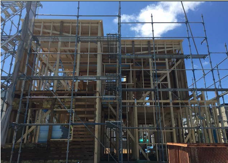
構造入替施工中 全景
