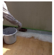
バルコニー防水工事
