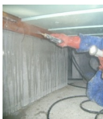
防蟻・防腐処理
